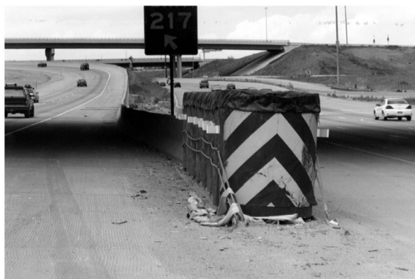
شکل پ ۳-۹- ضربه‌گیر جذبی بازکاربرد
