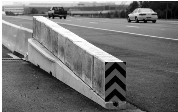
شکل پ ۳-۱- ضربه‌گیر مکمل انتهای حفاظ بتنی
