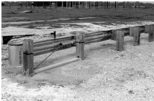
شکل پ ۲-۳- مه‌ار انتهایی با ریل شیاردار ۳۵۰ با فاصله جانبی ۱/۲ متر
