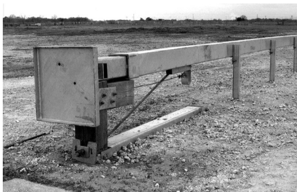
شکل پ ۲-۲- مهار انتهایی با تیر قوطی شکل وایومینگ (WYBET-350)
