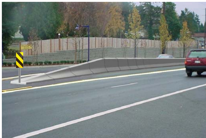
شکل ۲-۱۴- شیب‌دار کردن انتهای حفاظ بتنی
