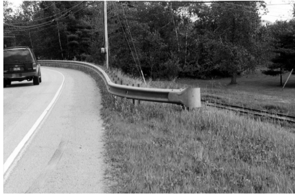
شکل پ ۲-۵- مهار انتهایی از نوع ورمونت
