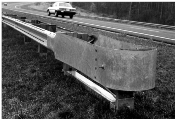
شکل پ ۳-۳- ضربه گیر انتهایی مستهلک کننده
