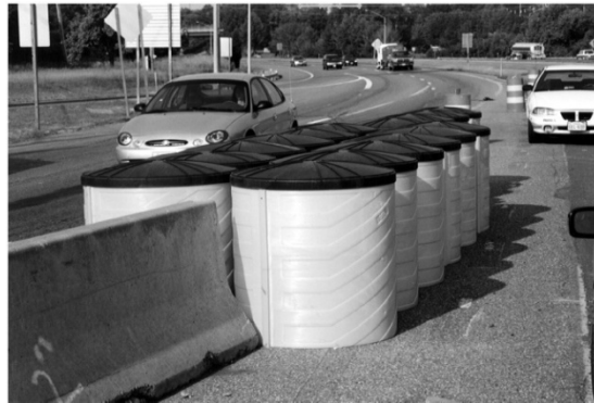
شکل پ ۳-۱۱ - نمونه‌هایی از بشکه‌های ماسه‌ای
