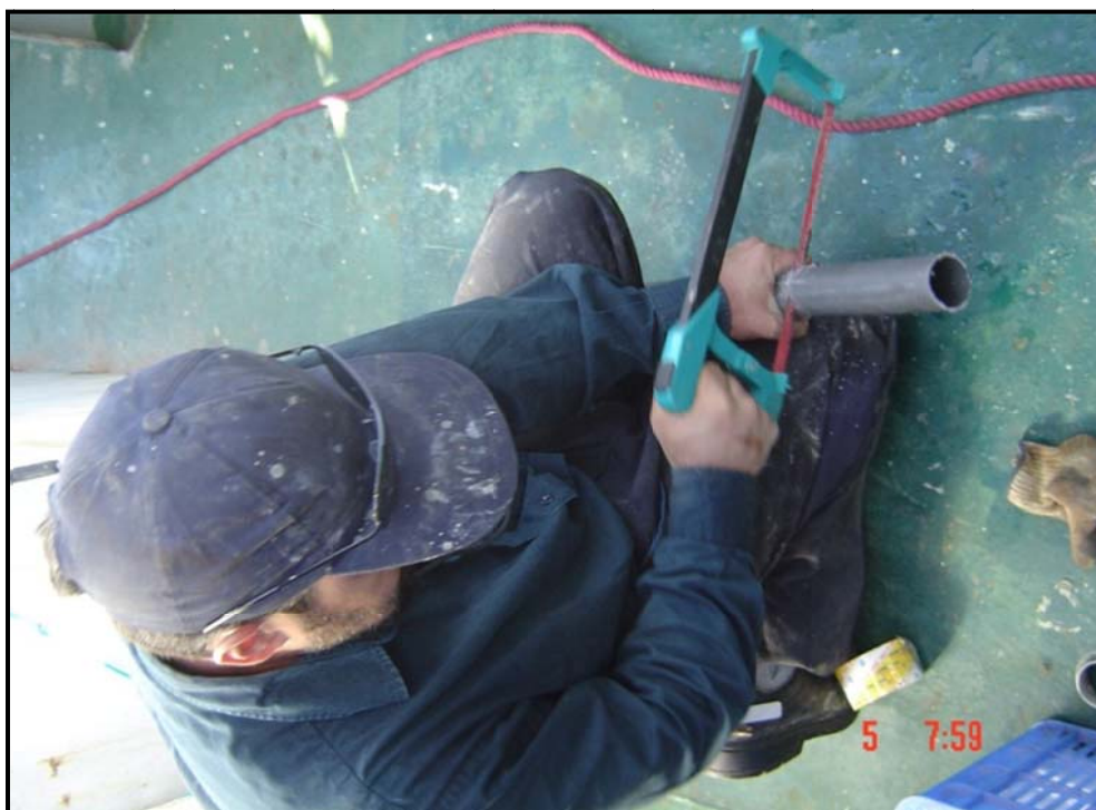
شکل ۲-۱۴- برش بخش اضافی لوله پی وی سی
