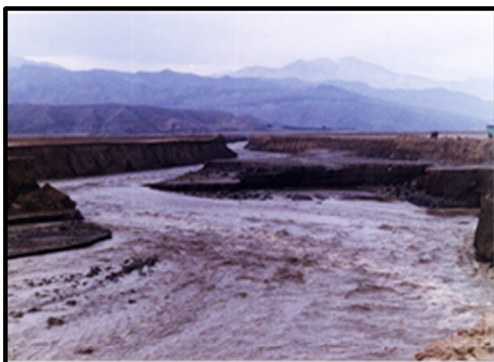
شکل ۱-۶- تعریض کانال تحت اثر فرسایش در حین عملیات رسوبزدایی منبع: کمیته‌ی رسوب سد سفیدرود
