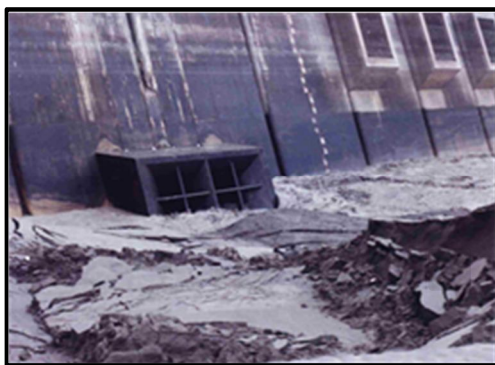
شکل ۱-۸- درهم کنش فرآیندهای هیدرولیکی و مکانیک خاک در ضمن آزاد شدن تدریجی منبع: کمیته‌ی رسوب سد سفیدرود
