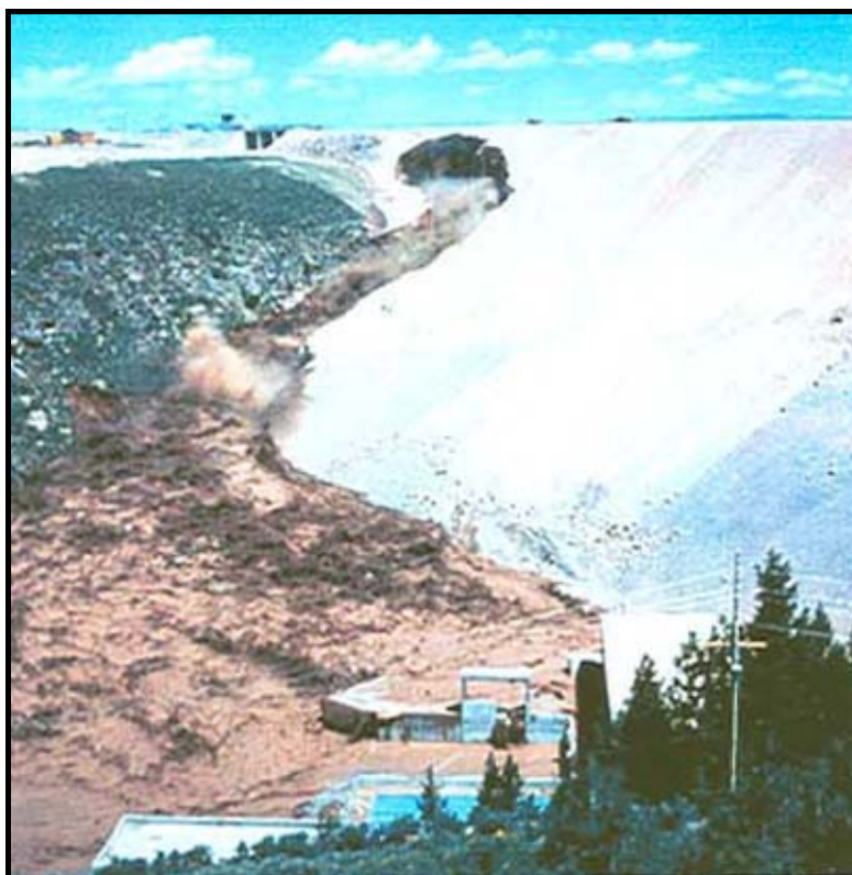
شکل ۳-۶- افزایش سریع ابعاد مجرای ایجاد شده در رویه سد و فرسایش شدید تکیه‌گاه راست
