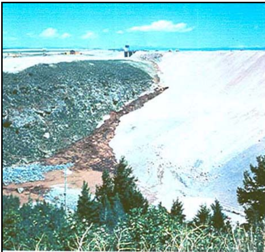
شکل ۳-۲- افزایش نشت به صورت یک جریان گل‌آلود
