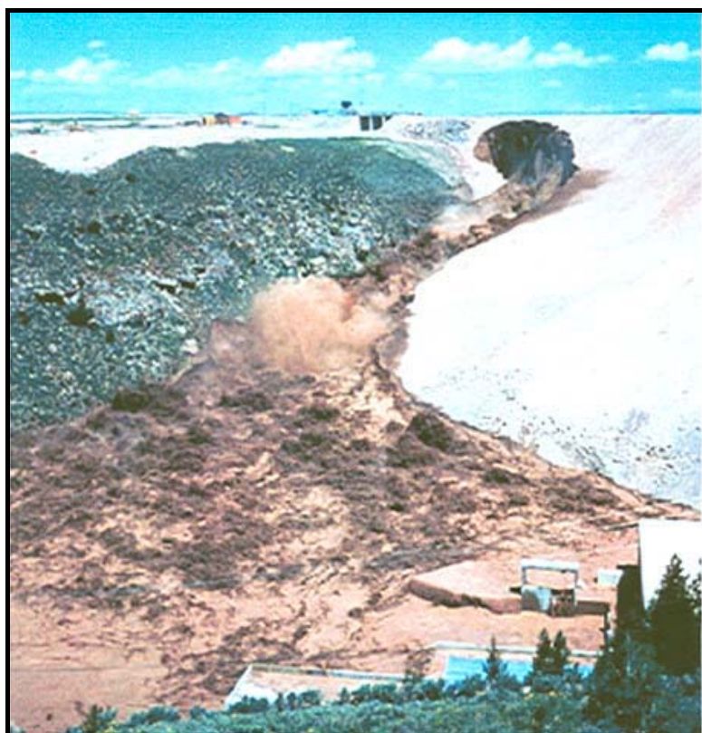
شکل ۳-۷- گسترش ابعاد سوراخ ایجاد شده در رویه سد تا نزدیکی تاج و هجوم آب و فرسایش عمیق در تکیه‌گاه راست سد
