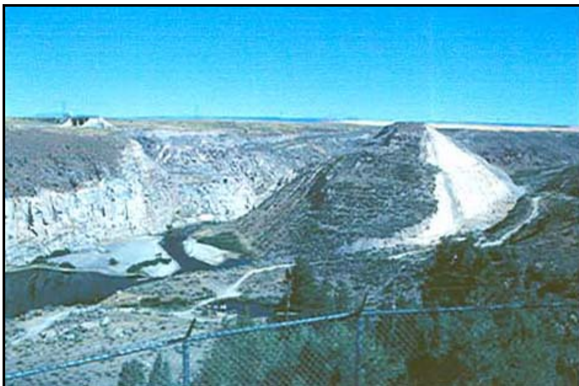
شکل ۳-۱۸- این عکس در آگوست ۲۰۰۱ از نزدیکی محلی که عکس‌های قبلی تهیه شده بود، گرفته شده است. تمام چیزی که از سد اصلی باقی مانده یک تپه هرمی شکل است.
