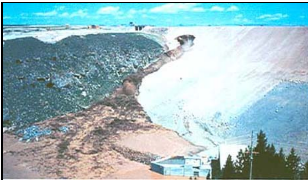
شکل ۳-۴- افزایش ابعاد مجرای ایجاد شده در رویه سد
