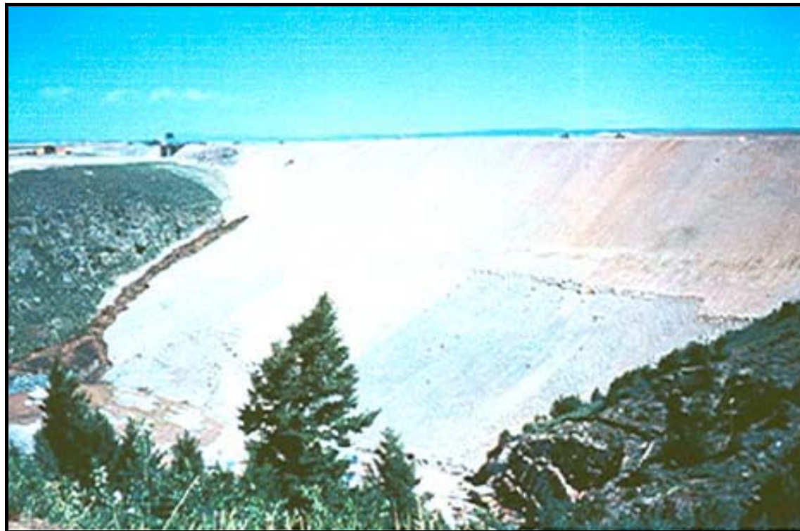
شکل ۳-۱ - ساعت ۱۰:۳۰ تا ۱۱ صبح، نشست به صورت یک خط قهوه‌ای تیره در رویه سد در سمت چپ عکس مشاهده می‌شود.
