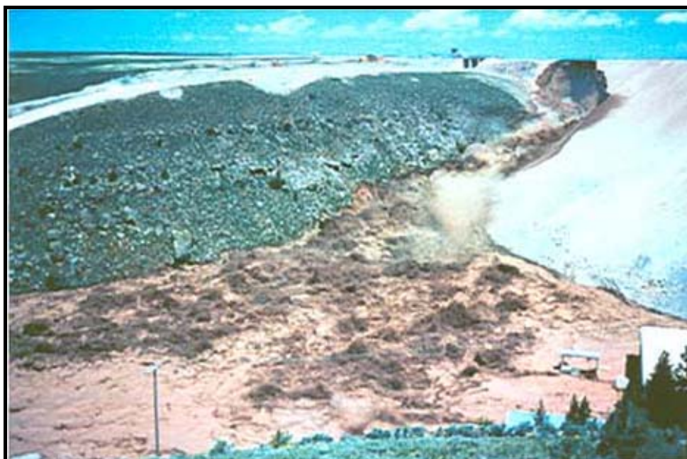
شکل ۳-۸- برش تاج سد با گسترش ابعاد مجرا و افزایش مداوم جریان سیلابی پایین دست
