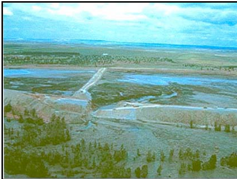
شکل ۳-۲۷- شکست سد رسوبگیر لوس فرایلس
