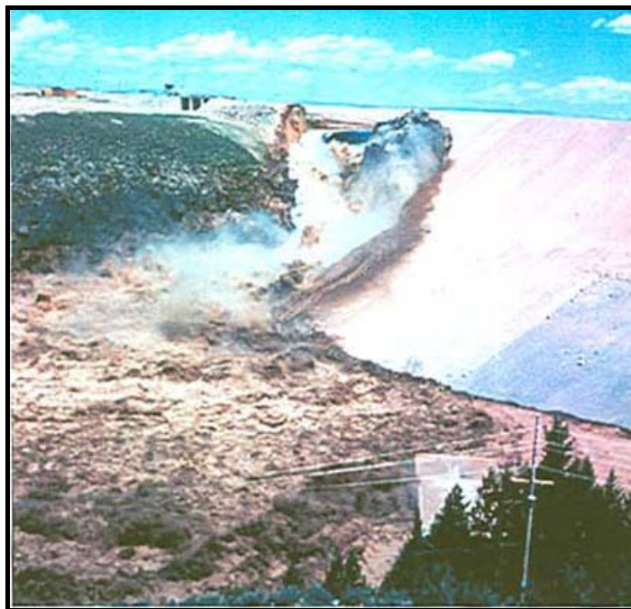
شکاف ۳-۱۲- افزایش شدت جریان آب با افزایش ابعاد شکاف سد
