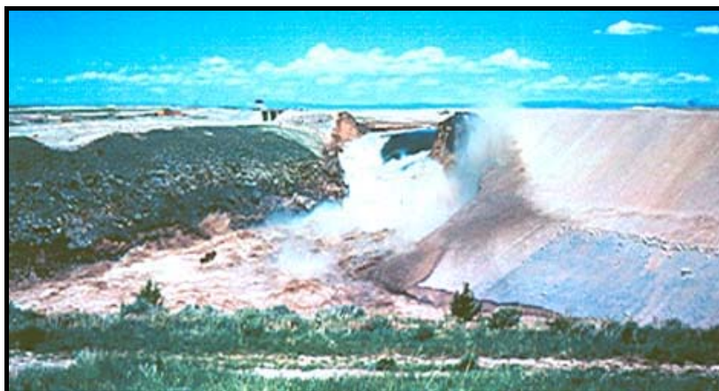
شکاف ۳-۱۳- نمایی دورتر از وضعیت شکاف سد و وضعیت سیلاب پایین دست
