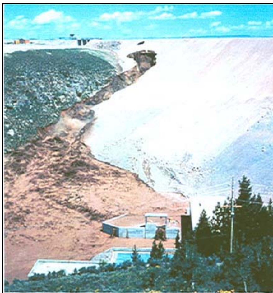
شکل ۳-۵- فرسایش تکیه‌گاه راست و ظهور یک نشت دیگر بالاتر از محل وقوع نشت قبلی و شکل گرفتن جریان سیلابی گل‌آلود در پایین‌دست سد
