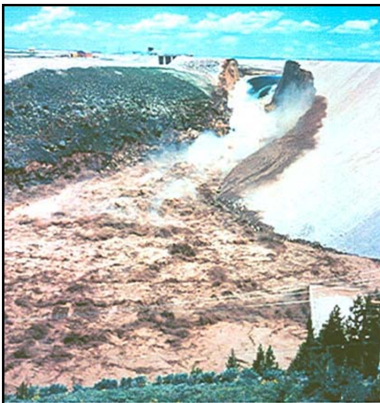
شکل ۳-۱۱- افزایش مستمر ابعاد شکاف سد
