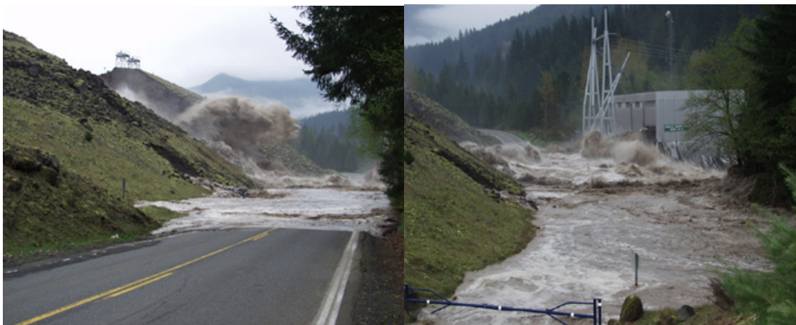
شکل ۲-۱۳ خرابی آبراه کولیتز ۱ در ایالت واشنگتن آمریکا
