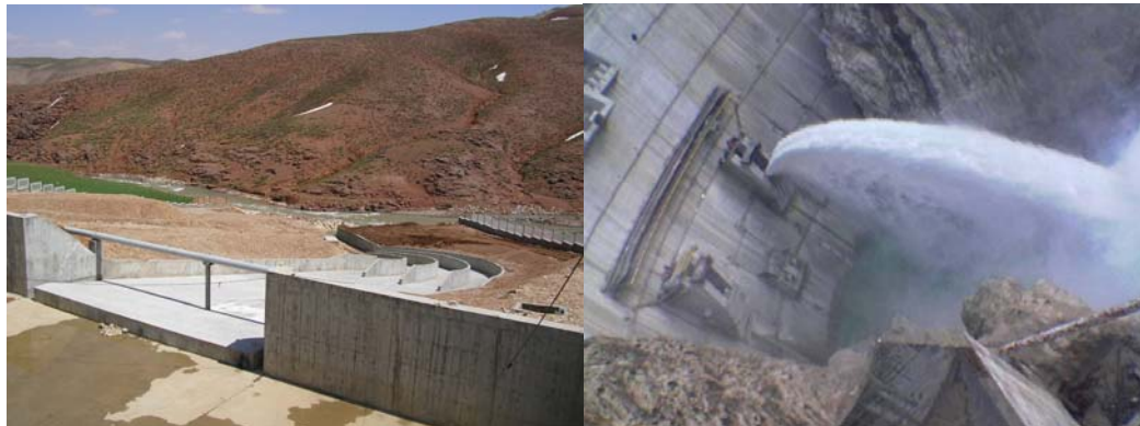
شکل ۸-۱ نمونه سرریز و تندشیب داخل بدنه در سد قوسی و روی بدنه در سد خاکی
