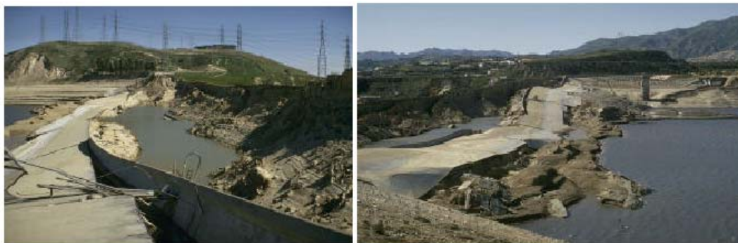
شکل ۲-۱ روانگرایی وسیع و لغزش شیروانی سد خاکی در زلزله
