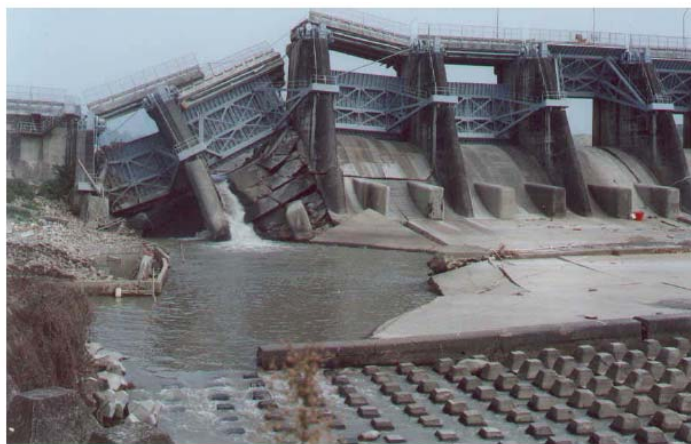
شکل ۲-۷ خرابی‌های سد انحرافی شی‌کانگ در زلزله چی چی تایوان
