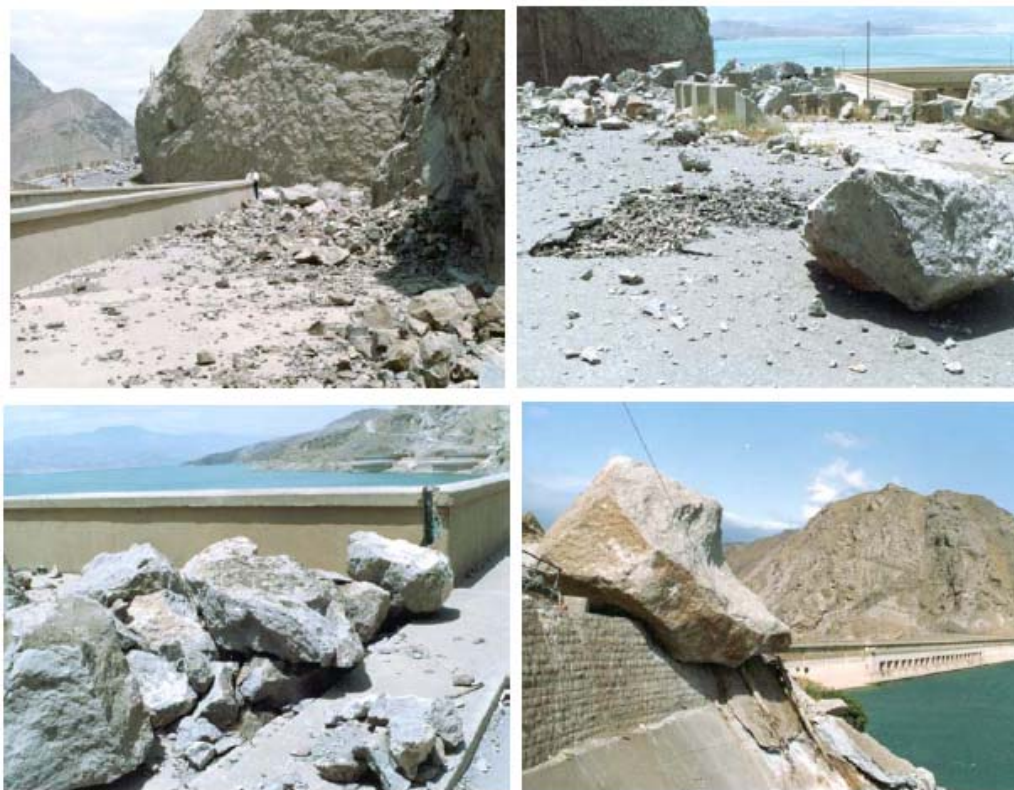
شکل ۲-۵ نمونه‌هایی از سقوط سنگ در محل سد سفید رود و در محدوده مخزن در اثر
