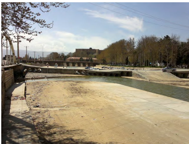
عکس ۱- نمای از بهسازی رودخانه خرم آباد
